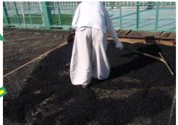
かくはん 攪拌されたゴムチップをまき、 トンボ つか を使って均します。
