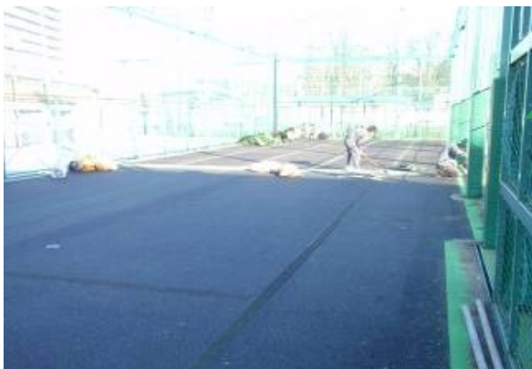
む た アスファルトが剥き出しになりました
